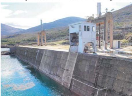
Betonске konstrukcije ventila na ulazu u tunele prema Platu. Lijeva nije u funkciji jer je drugi tunnel prokopan tek u dužini od stotinjak metara.
