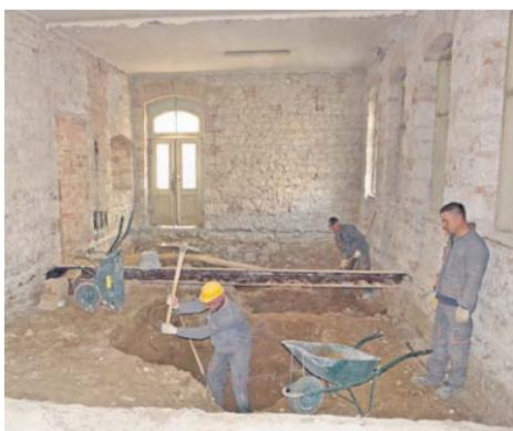
**R**adovi na sanaciji i rekonstrukciji zgrade idu prema planu. U tijeku je uklanjanje starih AB ploča. Iako je na originalnim nacrтima podrum ucrtao cijelom površinom, u stvarnosti je bio izveden tek na jednoj polovici. Fotografija prikazuje radnike tvrtke MGA kako otkopavaju zemlju u neizgrađenom dijelu podruma u kojem bi, prema planu, trebale biti pomoćne prostorije Prirodoslovnog muzeja.
