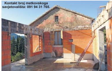
Dogradnja uz staru župnu kuću. Nedostaje svega osim volje za radom. Kruno kaže da su im do sada najviše pomogli gradovi Split i Metković, županija Dubrovačko-neretvanska te mnogi dobri ljudi. Na potezu je država.
