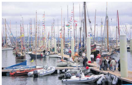
Pontoni, učvršćeni uza stupove zabijene u morsko dno, rješavaju problem plime i oseke
